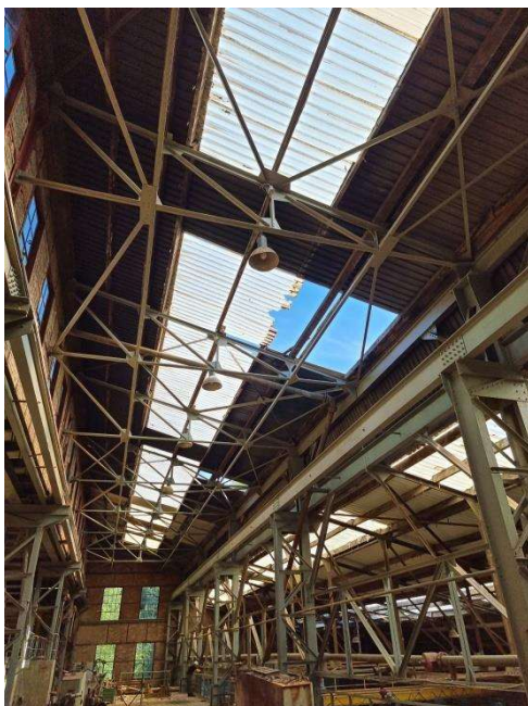
Abb. 18: Schäden am Dach der alten Steinbrechanlage nach dem Wintersturm im Februar 2022 (Quelle: Osnabrücker Dampflokfreunde e.V.)
