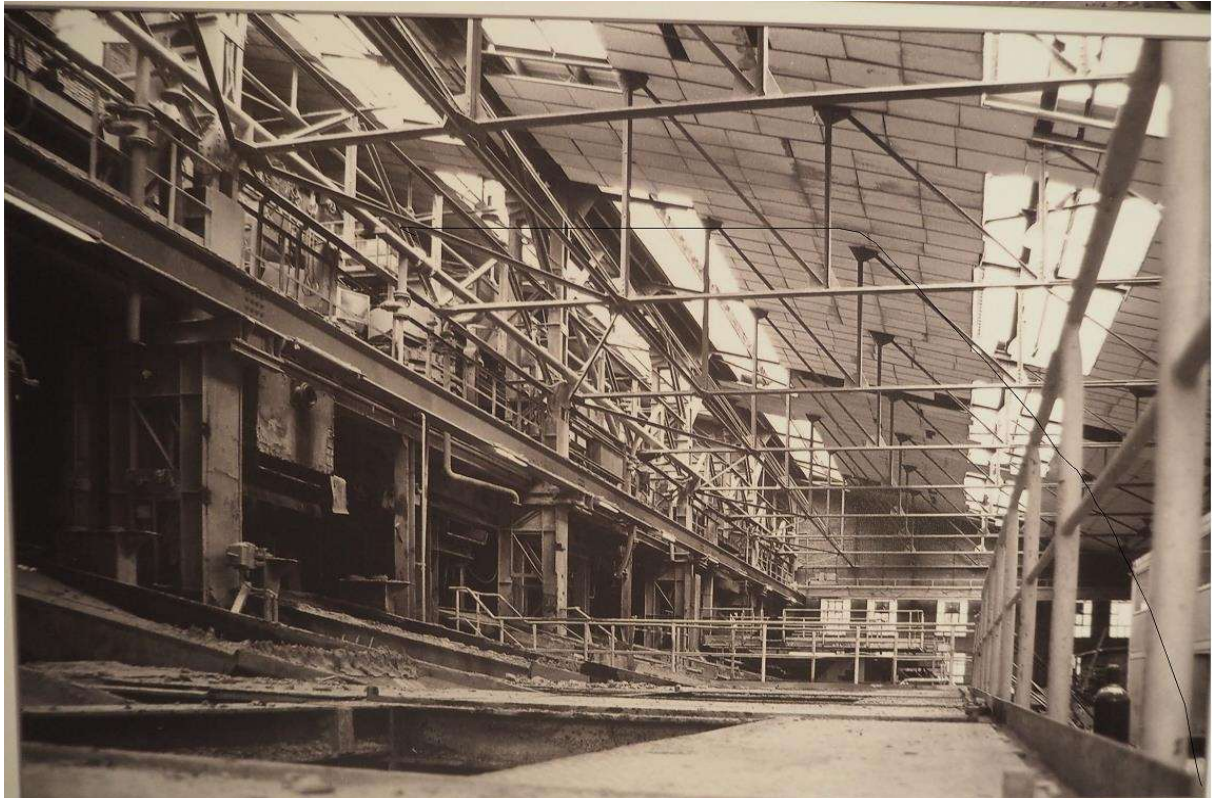
Abb. 8: Innenansicht mit bereits veränderter Dacheindeckung und einer abgehängten Decke (Quelle: Osnabrücker Dampflokfreunde e.V.)
